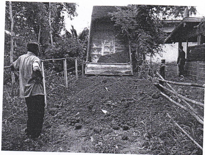
ขณะดำเนินงาน
