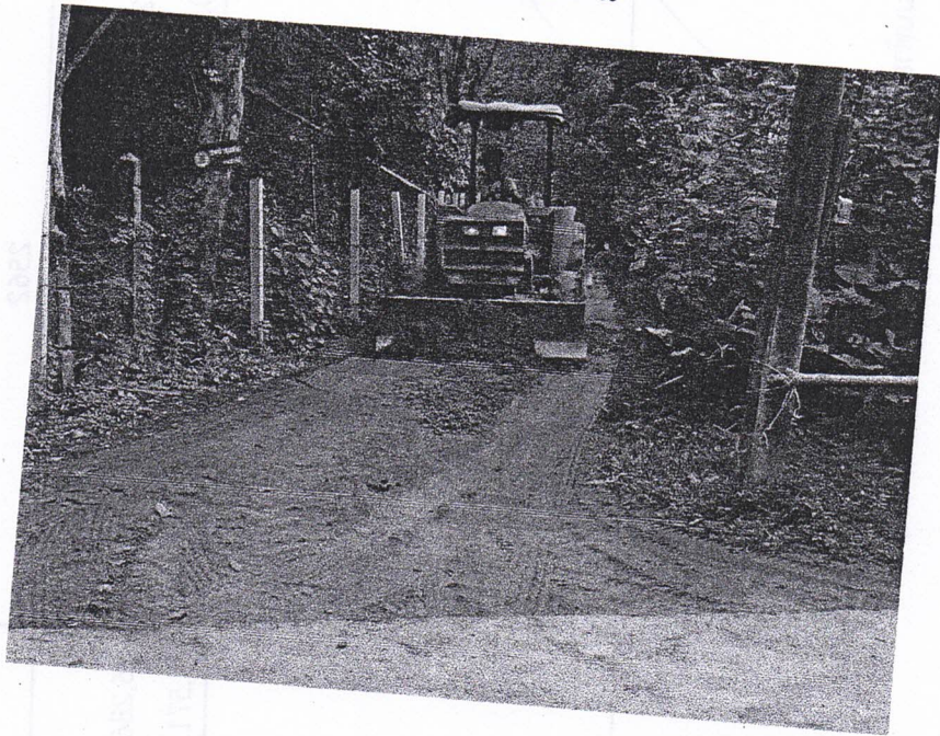
ขณะดำเนินงาน
